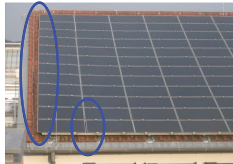
Wilde Verkabelung / Fehler bei der Leitungsführung
